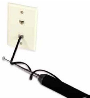
Рис. 7.10. Проверка радиочастотным зондом телефонной линии
